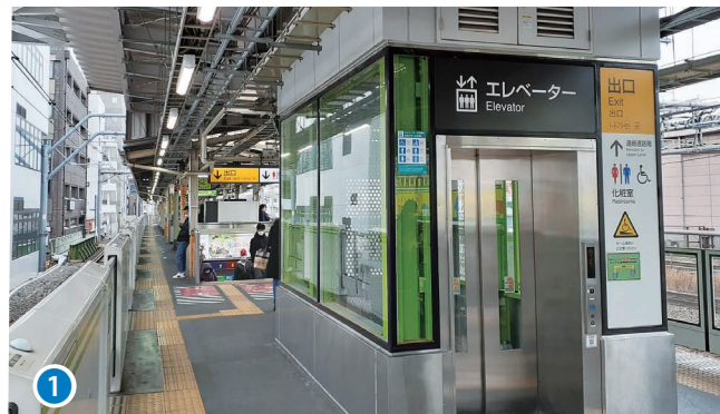
●工事の難易度が高かった、新大久保駅エレベーター
