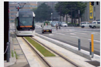
富山ライトレール富山駅北付近 軌道敷地と車道を緑色により分離
