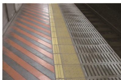
ホーム縁端警告ブロックの例（左：ホーム敷設例）（中：一体型）（右：分離型）
