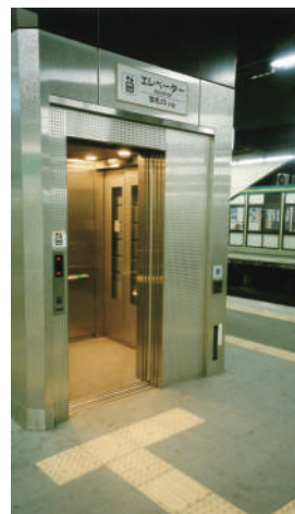
駅用直角二方向エレベーター（左：説明図）（右：設置例）
