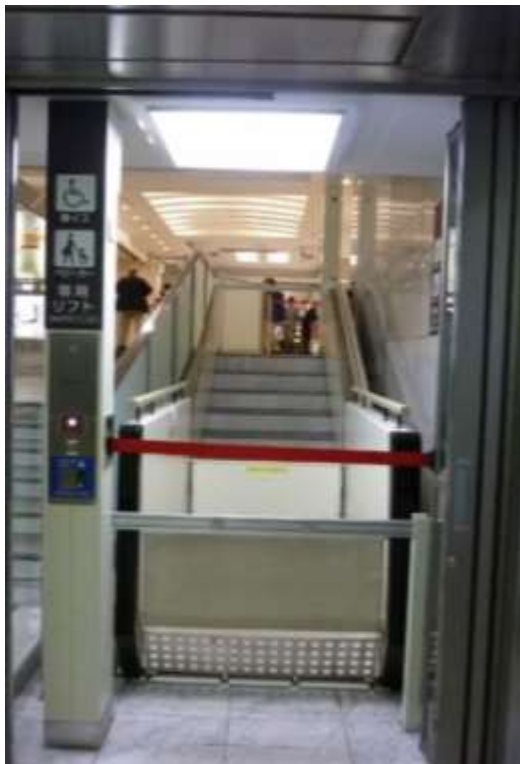
図 階段昇降機の利用案内（下段側） （商業施設）
