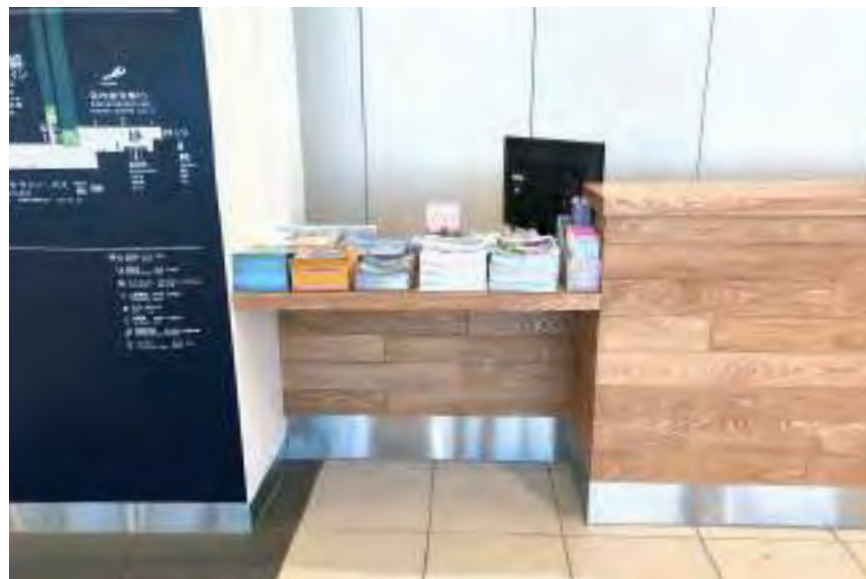
例2：案内カウンターのローカウンター上にパンフレットやぬいぐるみ等を置き、車椅子の利用の妨げになる。
