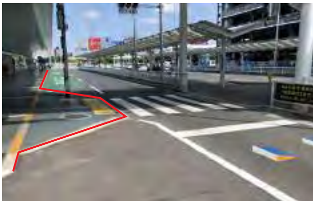
横断歩道接続部の歩道をテラス状に張り出すことで、車椅子でも安全に待合できる平坦部分を確保し横断距離を短くしている。
