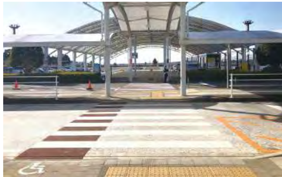
静岡空港/歩車道境界部の移動しやすさの確保
