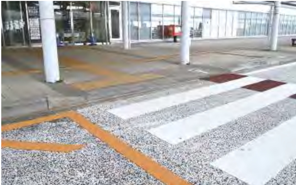
静岡空港／視覚障害者誘導用ブロックの適正敷設及び勾配処理により安全性が高められたカーブサイド
