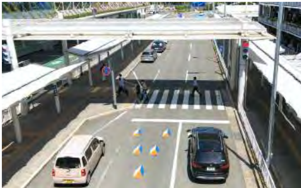
福岡国際空港 国内線/歩道前出しによる横断歩道の短距離化
