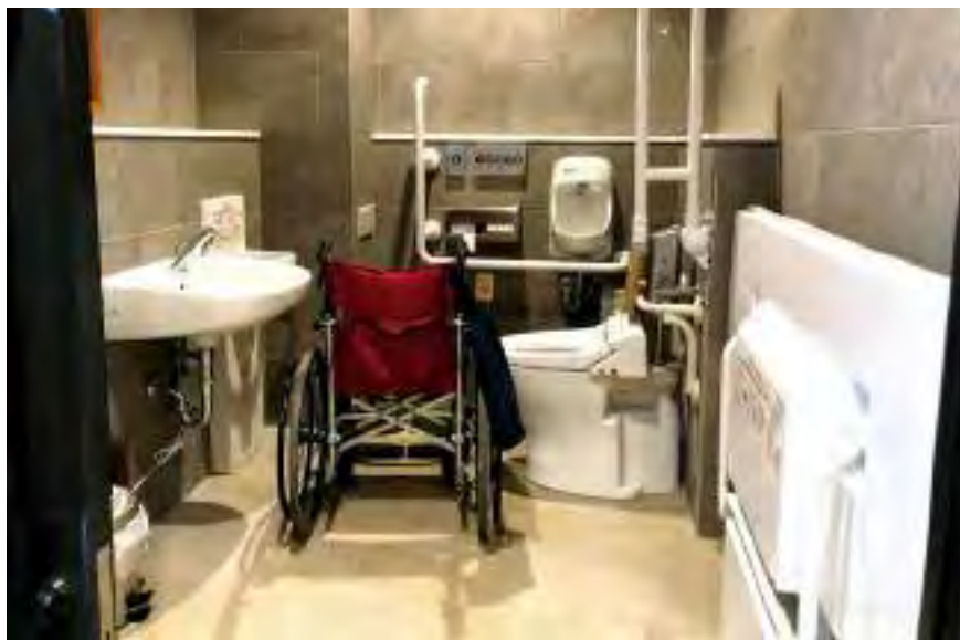
例1：バリアフリートイレに機能集中させたことで、車椅子での利用ができない、しにくい(特に大型電動車椅子)
