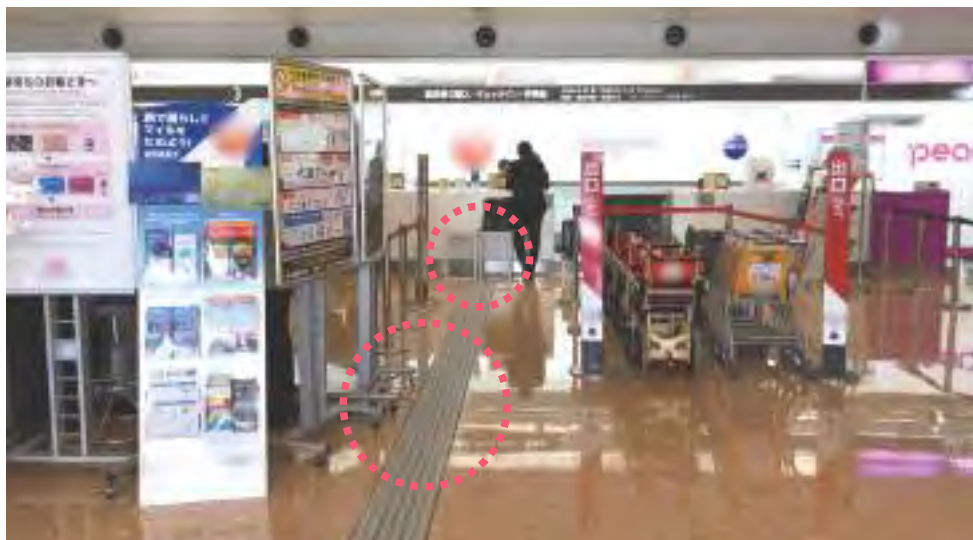
視覚障害者誘導用ブロック周辺の看板
