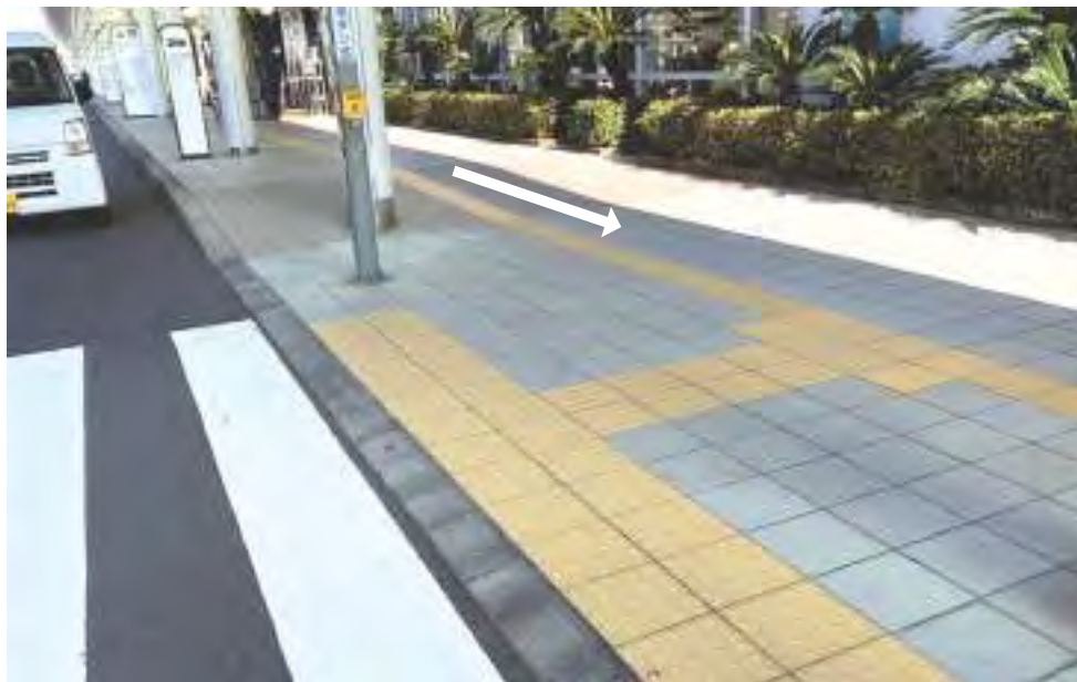
鹿児島空港／視覚障害者誘導用ブロックの適正敷設及び勾配処理により安全性が高められたカーブサイド
