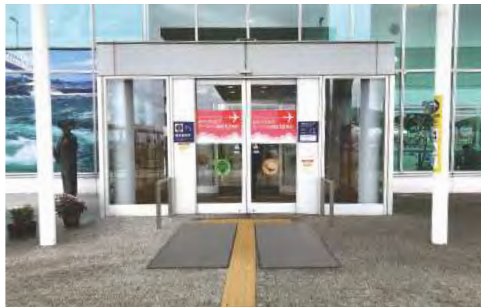
徳島空港／1階カーブサイド出入口
