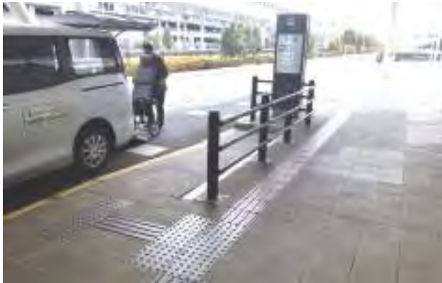
車両後方から乗降できるスロープを設置した乗降場。横乗りタイプのユニバーサルデザインタクシーも歩道高さがあるため乗降がしやすい。
