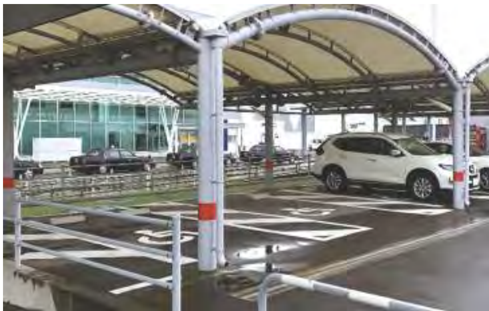
徳島空港 / 空港まで屋根が連続して設置されている障害者用駐車スペース
