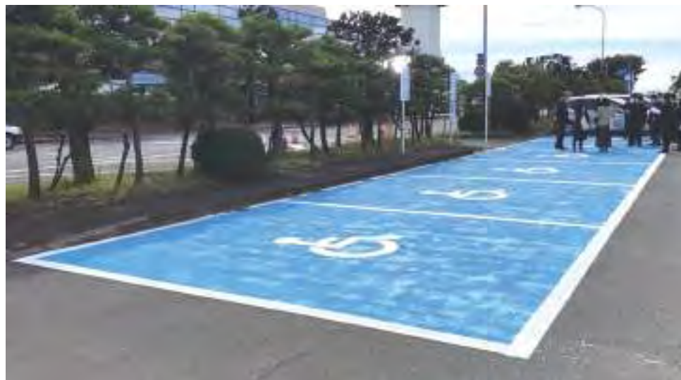
上方にサイン等の掲示がなく遠くからの視認性が懸念される障害者用駐車スペース
