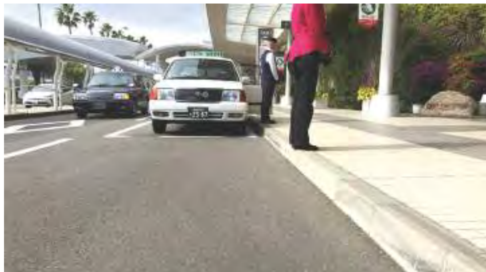
15cm程度の段差があり車道から歩道への上り下りが難しいタクシー乗降場
