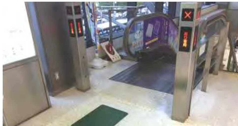
誘導用ブロック(誘導用マット)がエスカレーターの降り口部分に敷設
