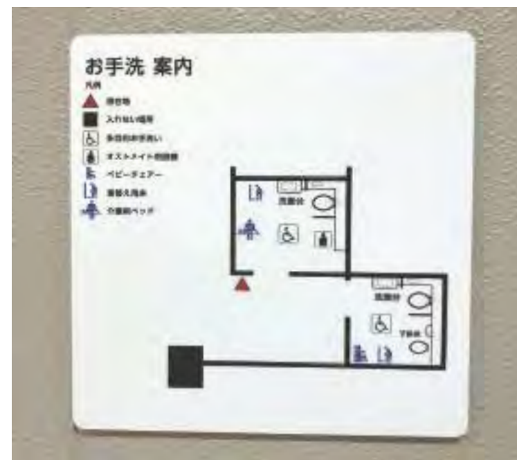
トイレ出入口に設置された触知案内図
