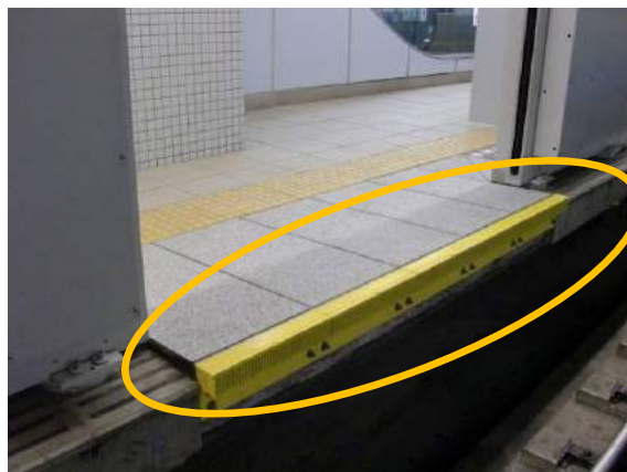
提供：大阪市高速電気軌道株式会社 長堀鶴見緑地線
