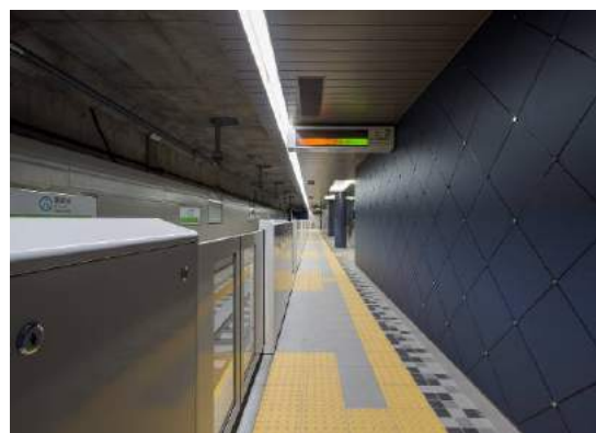
(緑薬師堂駅) ホームドア内側のと乗降位置の明るさを確保した照明
