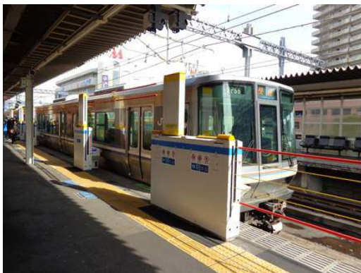
参考 3-1-6 : 可動式ホーム柵（昇降式）の例
