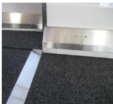
搭乗橋のつなぎ目部分の段差を解消
