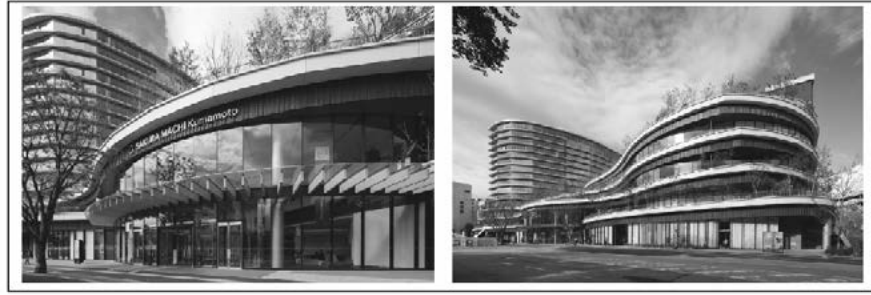
図1 サクラマチの外観の様子
