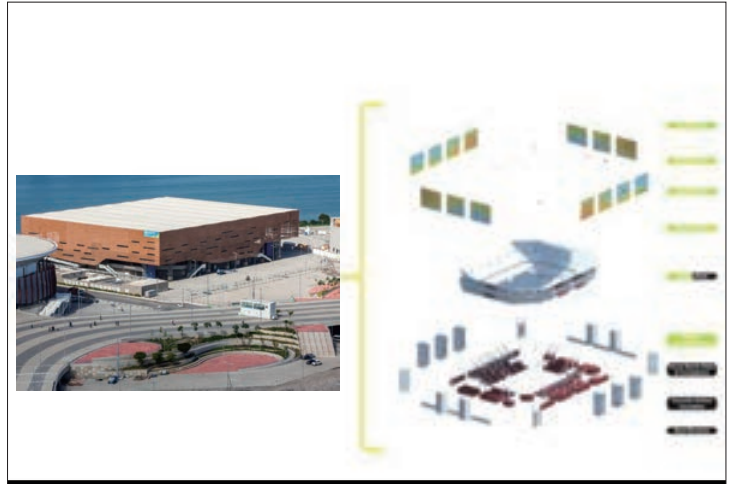
「ノマド建築」のコンセプトの元、建築を解体し、設備類を学校等に再利用予定
