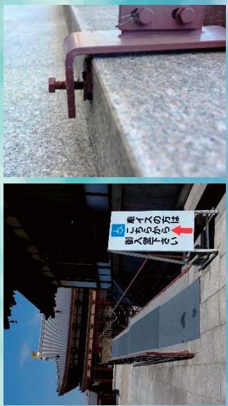
基壇にスロープを設置することで、車いすで、車いすすることでも簡単に入堂することができる。その際、クランプなど建物の間にゴム板を挟むことで、文化財を傷つけないように配慮している。
