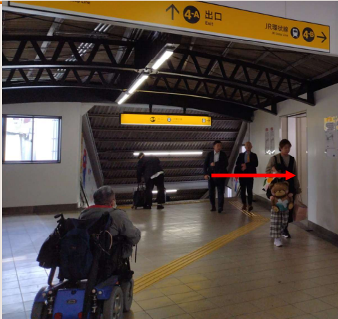
エレベーターの表示が小さい
