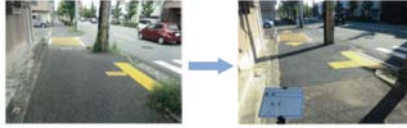
⑥横断歩道部に側溝がある場合、蓋の穴に車輪や杖をとられる。
