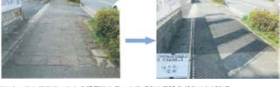
④マンホールとアスファルトの段差による、つまずきや車輪のガタツキがある。
