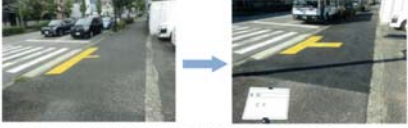
③インターロックの不陸の悪化による、つまずきや車輪のガタツキがある。
