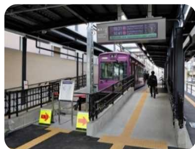
駅ホームへの スロープ・誘導ブロック設置 (京福電鉄)
