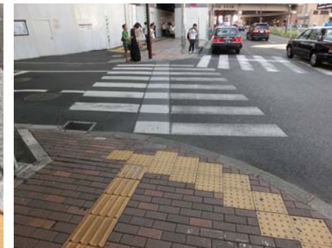
線状ブロック、縁石の方向の ずれをフォロー
