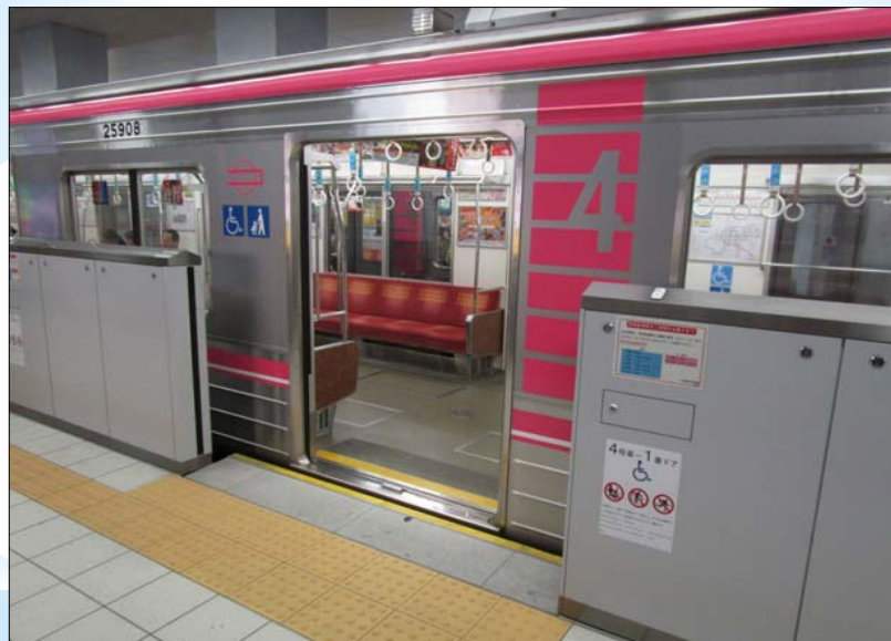
施工完了後 (千日前線)
