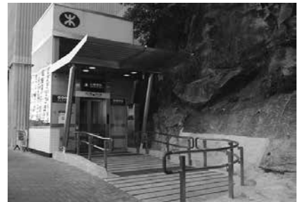
エレベーター
