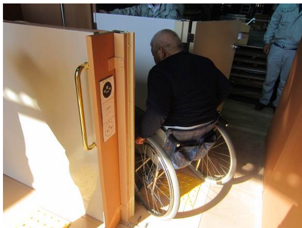
扉受に後輪がひっかかっている
