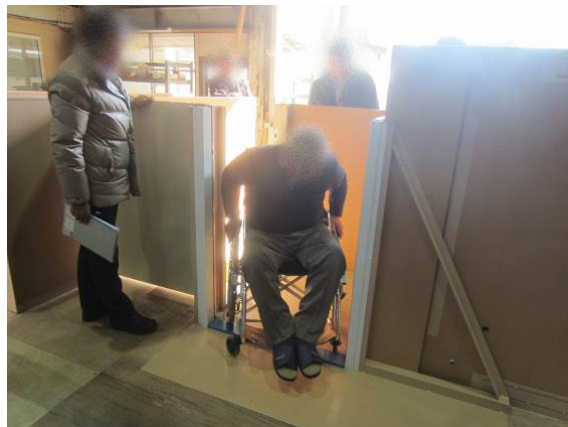
斜めの退出角度となるに加え、扉受が障害となっている
