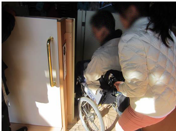
斜めの進入角度となるので幅に余裕がない
