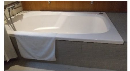
⑦ 浴室内で滑らない工夫がない
