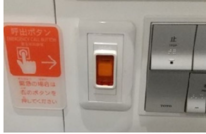
⑦ 緊急通報ボタンは押しボタンのみである。(船全体がそう)
