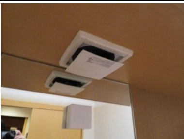
⑤ 空調の操作が天井にあり、車椅子の方の操作は不可能である
