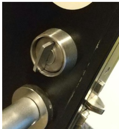
⑨ 鍵のサムターンが小さく操作が困難である
