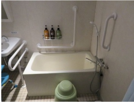
⑥ 浴槽を使わない人にとって、シャンプー、リンス等の備品に手が届きづらい構造である
