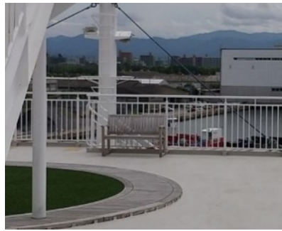
⑥ 手すりでの動線上にベンチが設置されている
