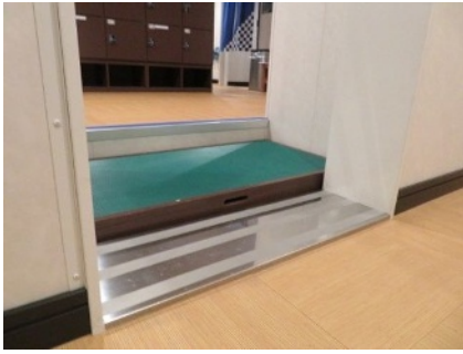
③ 入口に段差がある
