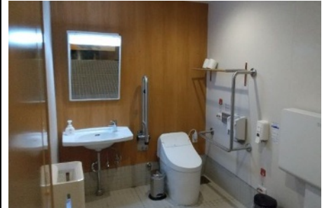
⑧ 介助者と当事者を仕切る配慮(カーテンや仕切り)はない
