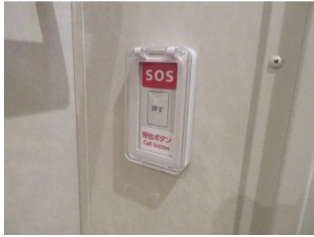
⑦ 緊急通報ボタンは押しボタンのみである。(船全体がそう)
