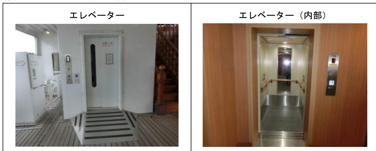
図表 3-1-3 エレベーターの例
