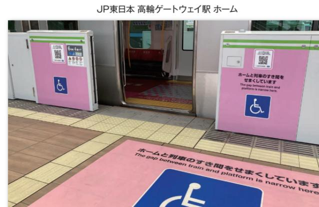
段差・隙間の解消された場所をホーム床面、ホームドアに表示している例
