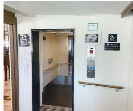
エレベーター 四国フェリー(株)・香川県高松市
