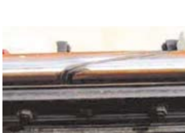
(斜め接着絶縁継目)
