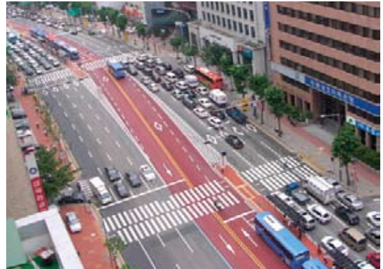
ソウルのBRT（Bus Rapid Transit）道路中央にバス専用走行路がある。
