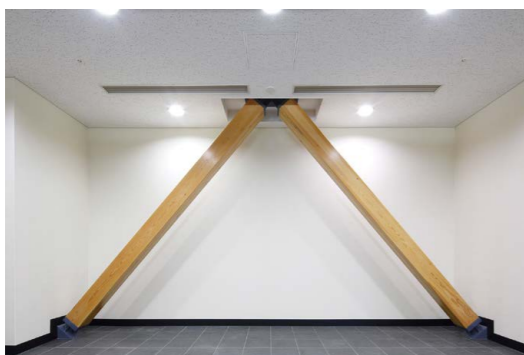
集材材を用いた「耐震ブレース」
