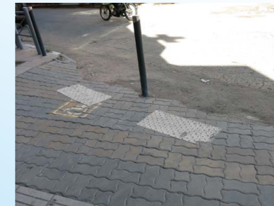
道路は整備されているにもかかわらず、連続性、維持管理が不十分な状態です。
