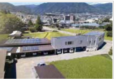
車庫の屋根のソーラーパネル
