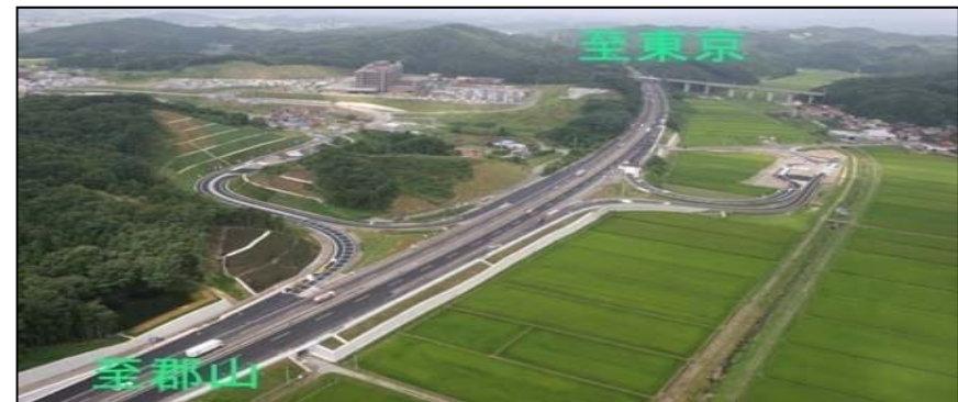
図 本線直結型スマートインターチェンジの 例(白河中央スマートインターチェンジ)
