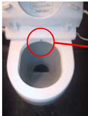
便器に備え付けられた洗浄ノズル（オストメイト対応）
