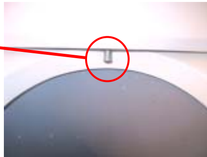
便器に備え付けられた洗浄ノズル（オストメイト対応）
