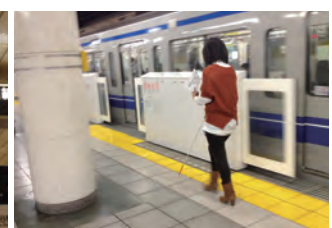
ホームドアと床面の境界／ 点字ブロック／タイル目地
