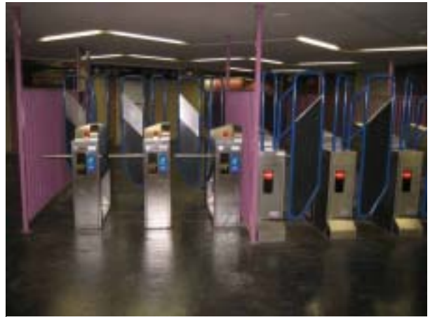
厳重なすり抜け防止策をした地下鉄の自動改札機
