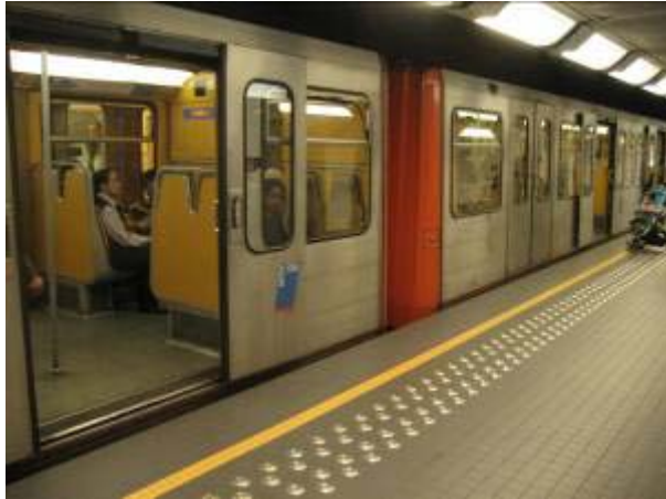
地下鉄(縁端警告ブロックは金属製の大型鋳)
