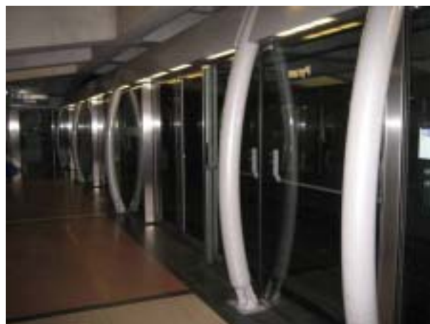
同左(開口部の警告ブロック案内等はない)
