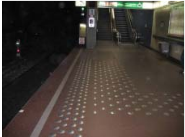
ホーム上の注意喚起警告ブロック(大型の金属鋳)
