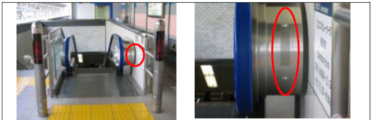
(東京地下鉄東西線行徳駅)
