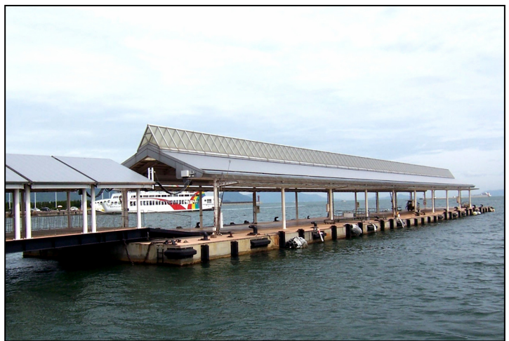
写真 栈橋・岸壁と連絡橋
