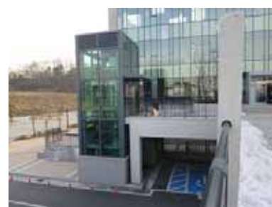
（地下駐車場からのエレベータ）
