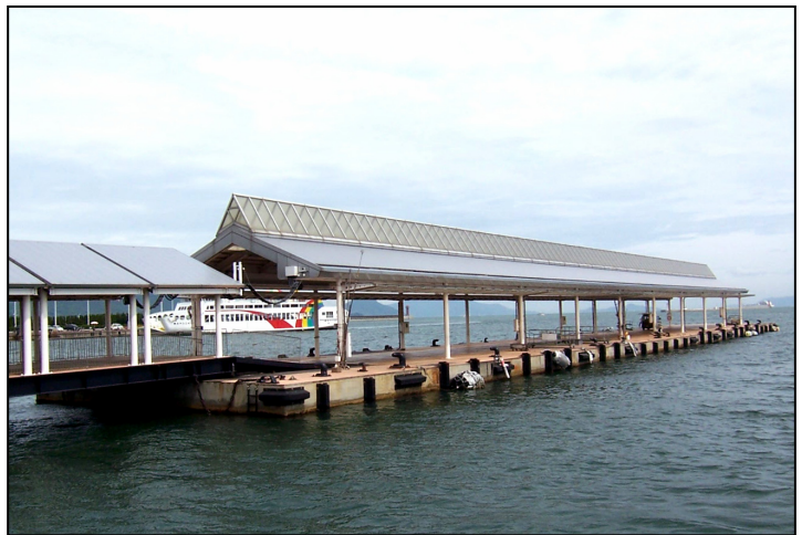
写真 栈橋・岸壁と連絡橋
