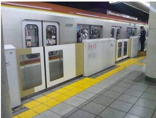
参考 3-1-6：可動式ホーム柵（昇降式）の例
