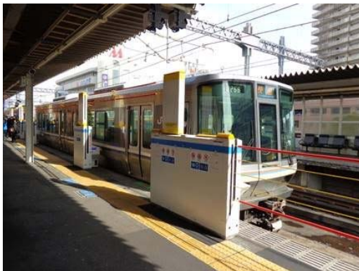
参考 3-1-6：可動式ホーム柵（昇降式）の例
