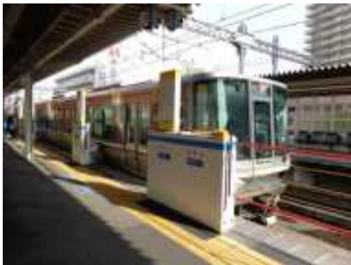
参考 3-1-6：可動式ホーム柵（昇降式）の例
