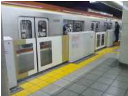
参考 3-1-6：可動式ホーム柵（昇降式）の例
