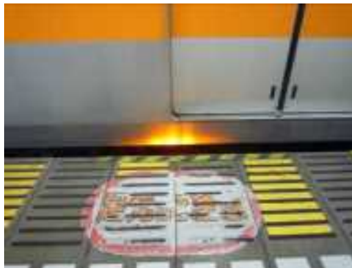
参考 3-1-10-3 : 回転灯等を設置して転落の危険に対し注意喚起している事例
