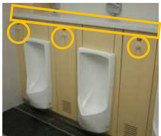
小便器の横に設置される例
