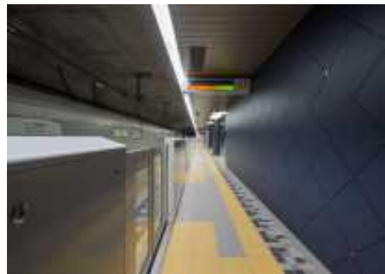
（緑葉師堂駅）ホームドア内側のと乗降位置の明るさを確保した照明
