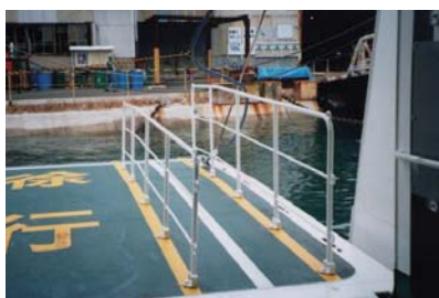
ランプ通路の手すり
