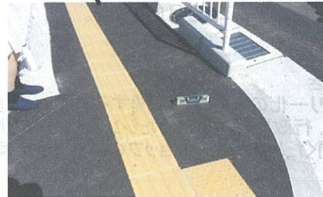
写真-2 約10%の縦断勾配
