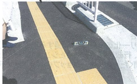
写真-2 約10%の縦断勾配
