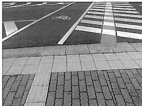
図-4 エスコートゾーンへ接続できていないケース
