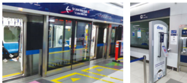
ホームドアをはじめバリアフリー化されたMRTと駅構内の遠隔通信の旅客案内端末（dina）
