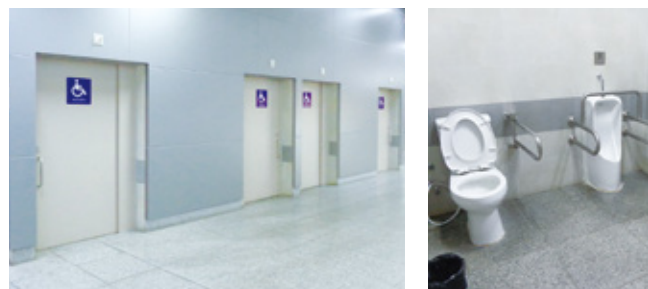
将来の旅客増を見越して設置基準を超えるバリアフリートイレを整備している（同駅）
