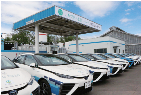
●北海道内唯一の定置式水素ステーション 「しかおい水素ファーム」
