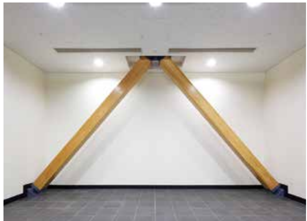
集成材を用いた「耐震ブレース」
