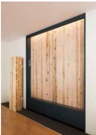
木質パネルを用いた「耐震壁」
