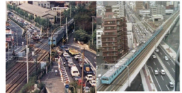
JR阪和線連続立体交差事業(大阪市)
