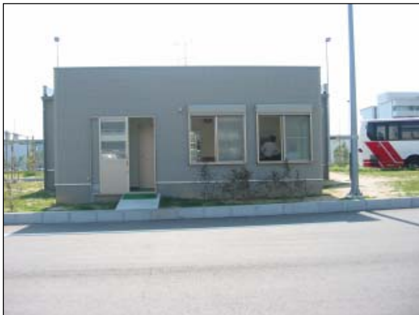
写真 IV-2 待機所の外観
