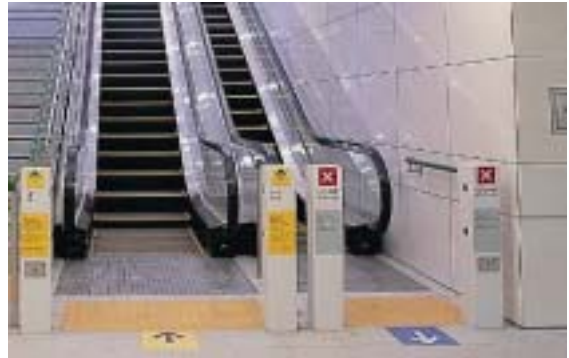
(福岡市交通局七隈線駅構内)
