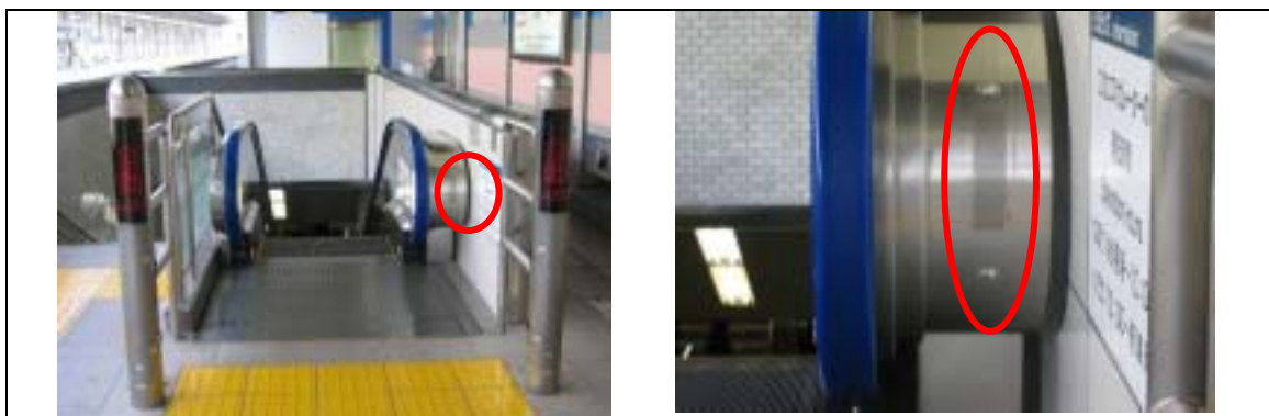
（東京地下鉄東西線行徳駅）
