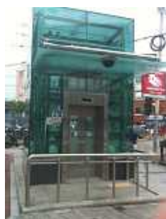
エレベーターの地上部はシースルー
