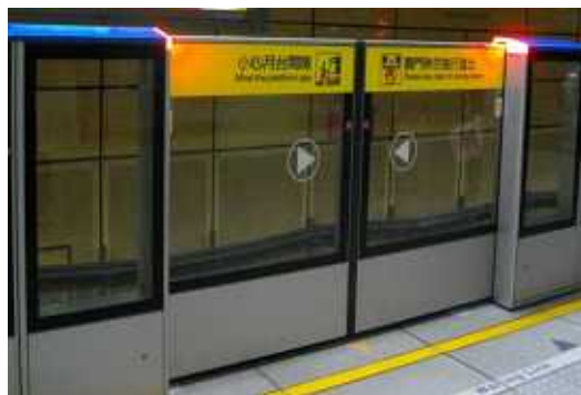
ホームドアの開閉時にランプが点滅
