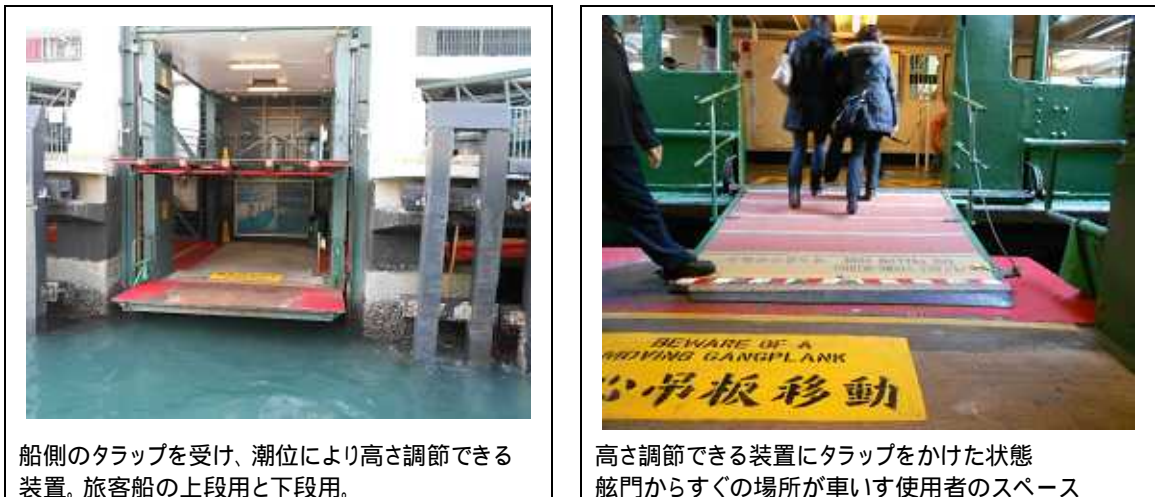
図 3-37 潮位の干満差により岸壁の高さを調整する装置
