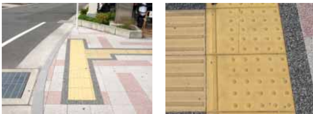
写真0.1 「点・線混合ブロック」の敷設例（沼津駅北口）
