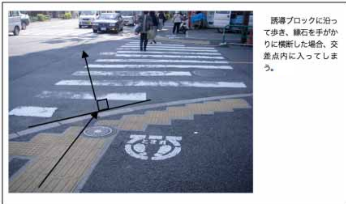
写真2.5 縁石が横断方向に対して直交していない事例（杉並区桃井四丁目）
