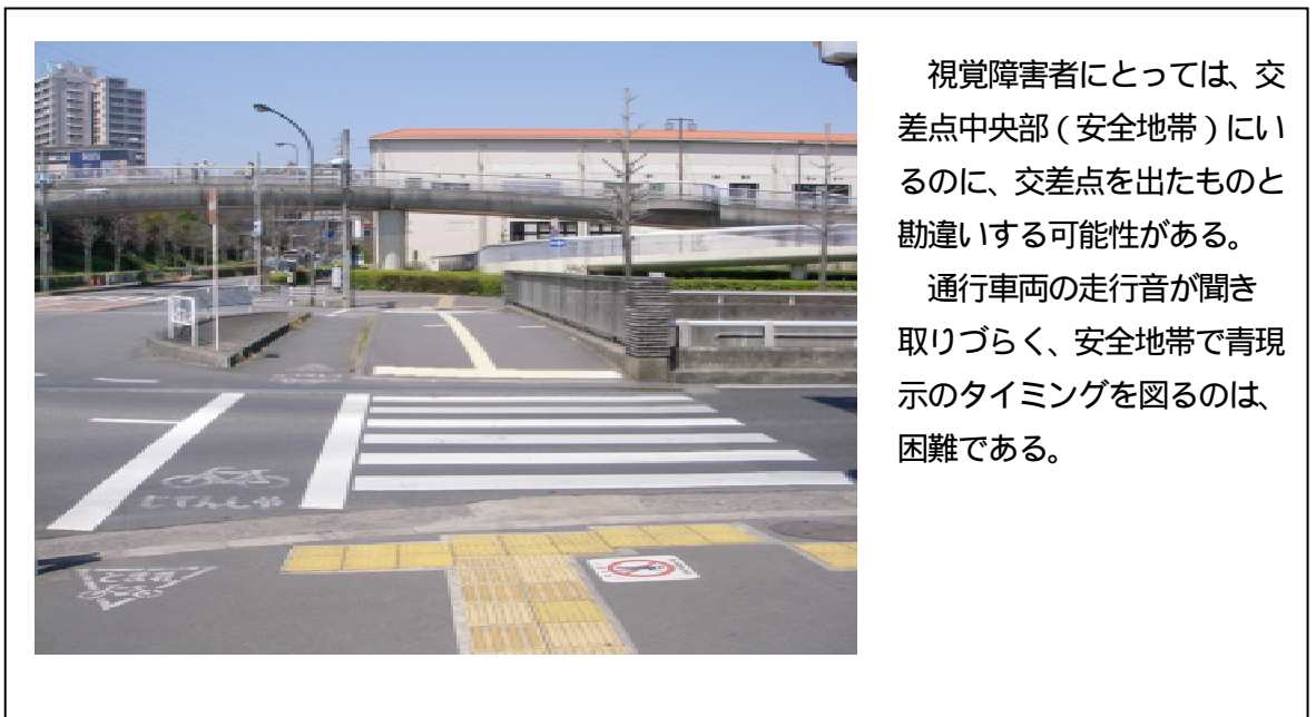
写真2.3 横断歩道幅より長い安全地帯のある交差点（八王子市南大沢）
